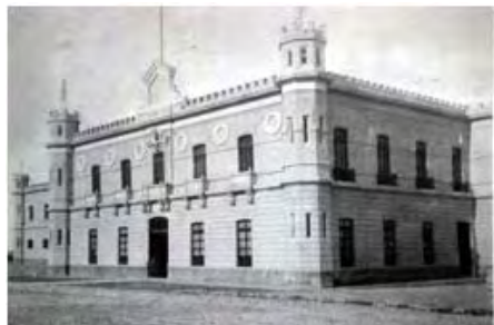
ARQUITECTURA PENITENCIARIA CÁRCEL DE LECUMBERRI
