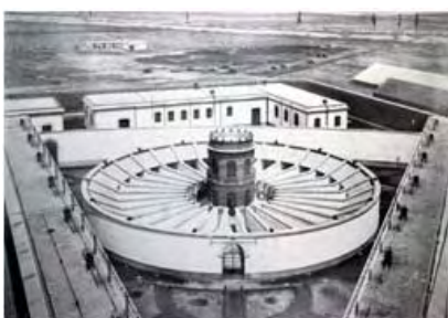
ARQUITECTURA PENITENCIARIA CÁRCEL DE LECUMBERRI.
