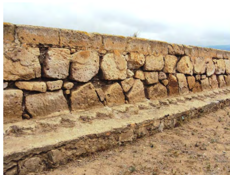
CAMINO A CUBIERTO, PARAPETO Y VESTIGIOS DE PALIZADA
