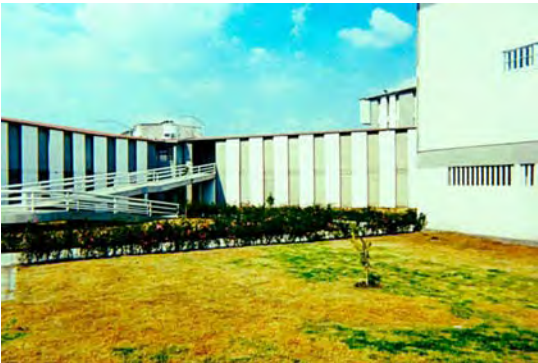
INGRESO DE VISITAS
