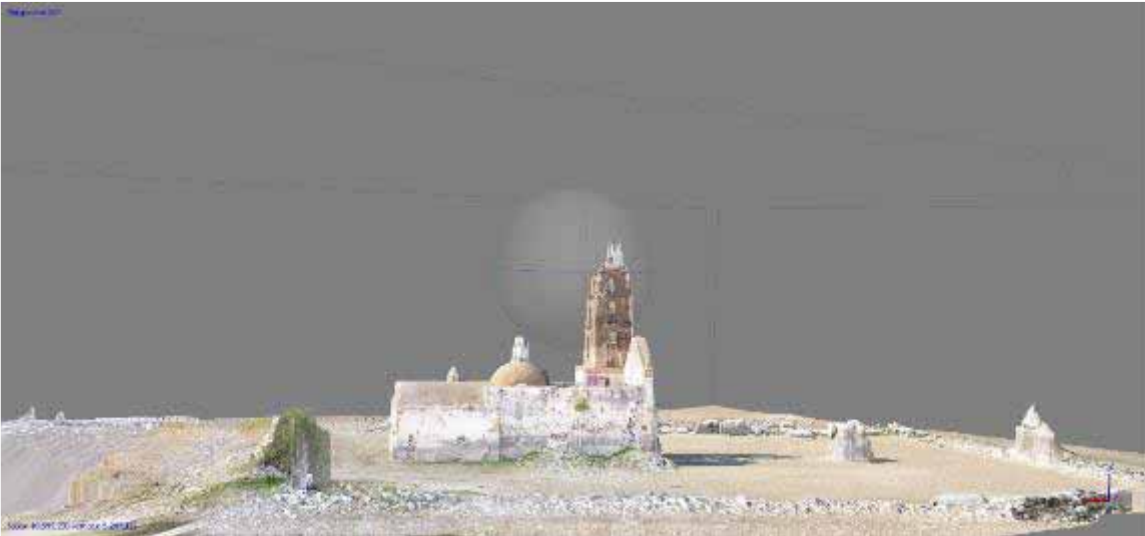
Figura 50. Vista lateral izquierda completa con pozo y muro de entrada principal.
