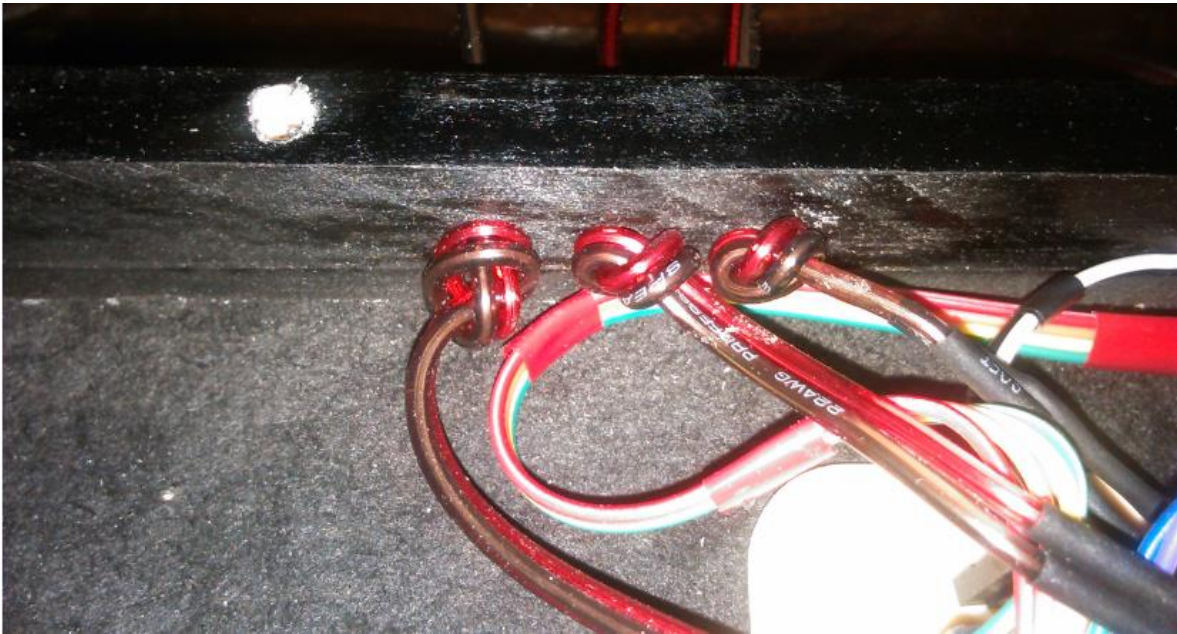
Figura 105. Nudos para evitar desplazamiento de los cables hacia el exterior.
